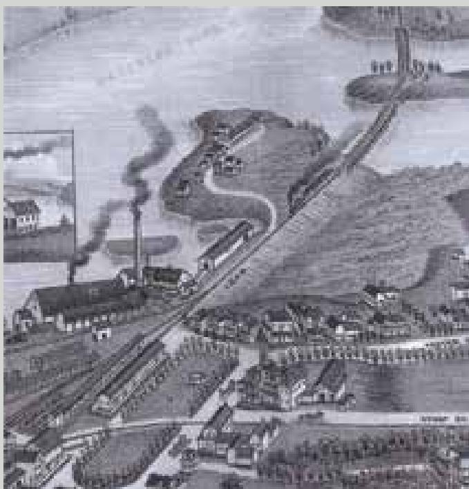
La vue à vol d'oiseau de Waterloo parue en 1881 permet de visualiser l'ensemble des installations de la tannerie (numéro 10), qui a la réputation d'utiliser une machinerie « moderne », alimentée à la vapeur. On distingue bien la haute cheminée, les hangars à peaux ainsi que les petites maisons pour les ouvriers au Pré-sec. Détail de Bird's Eye View of Waterloo, P.Q., 1881 , Wellge Henry.
