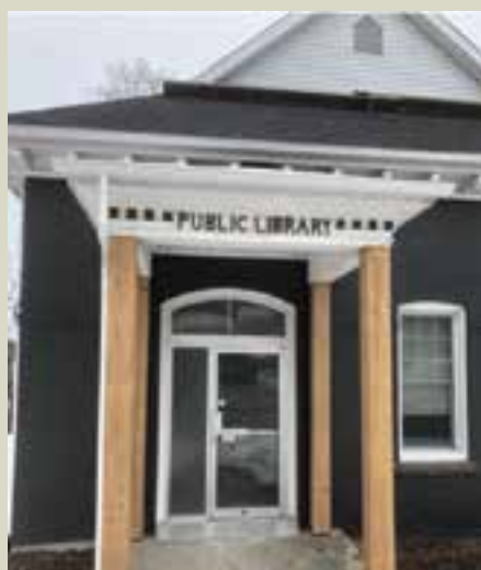
Au moment de prendre cette image, la bibliothèque est toujours en travaux.
