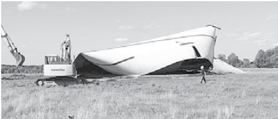
Le réservoir municipal enfin démoli pour faire place à un nouveau contenant le même volume d’eau mais sera plus large et plus bas. Cette construction d’acier vitrifié, intérieur et extérieur, sera d’un beau bleu foncé.
